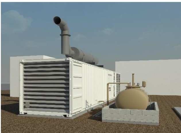
Vista en 3D de uno de los dos grupos electrógenos instalado
