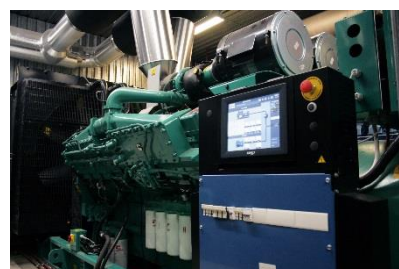
El grupo electrógeno de 1800 kVA instalado en Tromso es el primer producto de la gama KD SERIES implantado en Noruega
