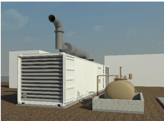
Vue 3D de l'un des deux groupes électrogènes installé sur site
