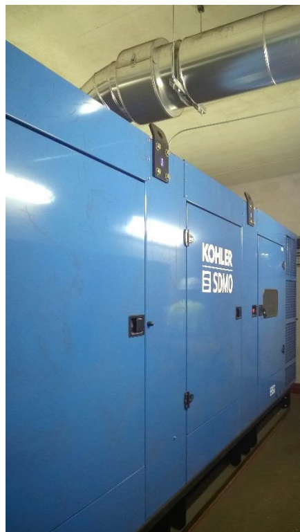
Ilustr. 2: El flamante grupo electrógeno KD1100 en versión carenada instalado en el local
