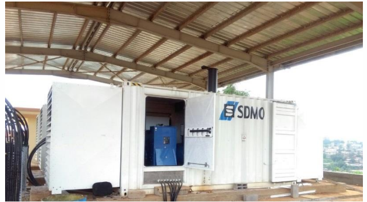
Illus. 1. Installation des groupes dans 3 conteneurs ISO20 Super Silent
