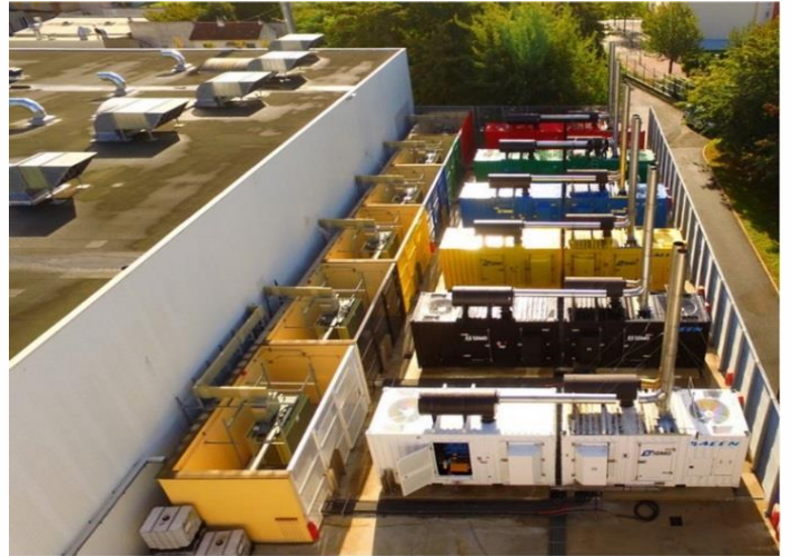
Ilustr. 2. Los seis nuevos grupos electrógenos se conectaron a la primera instalación y cada uno de ellos tiene un código de color definido.
